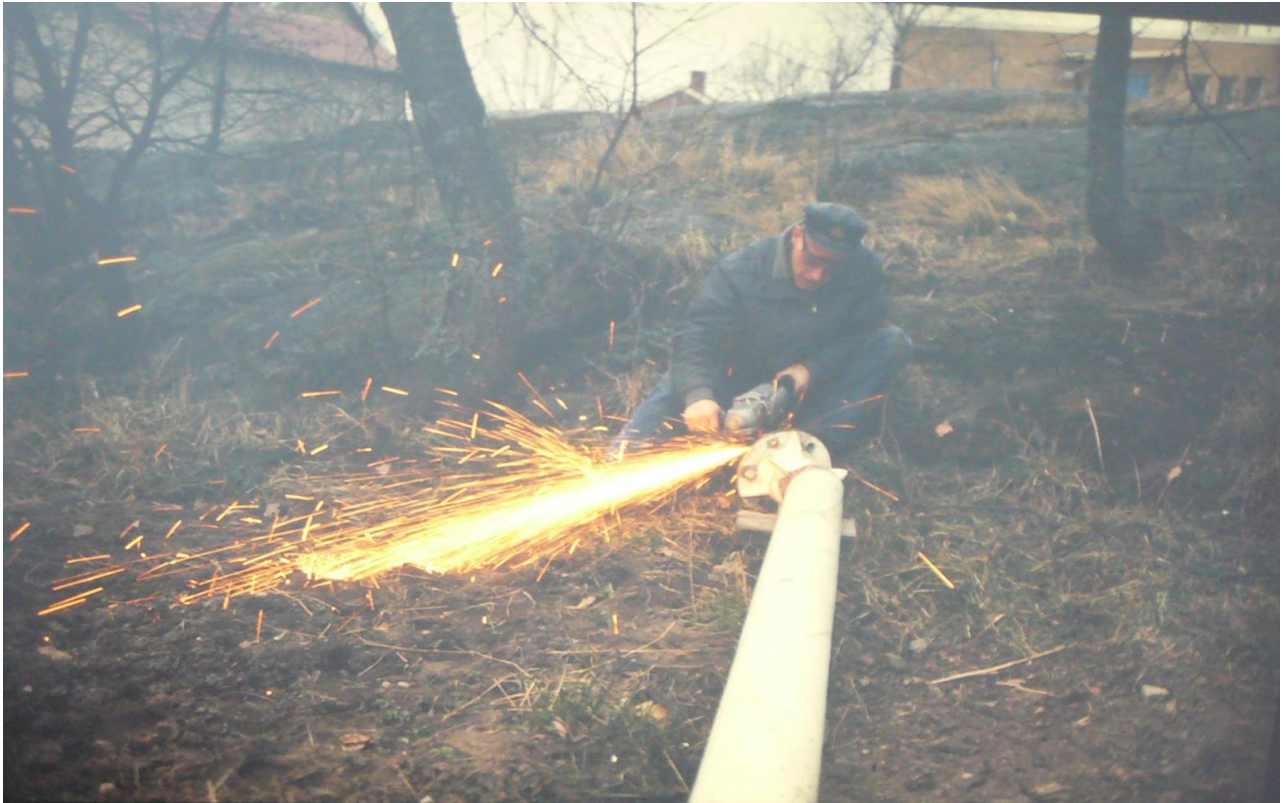
Ny mastkran byggs.
