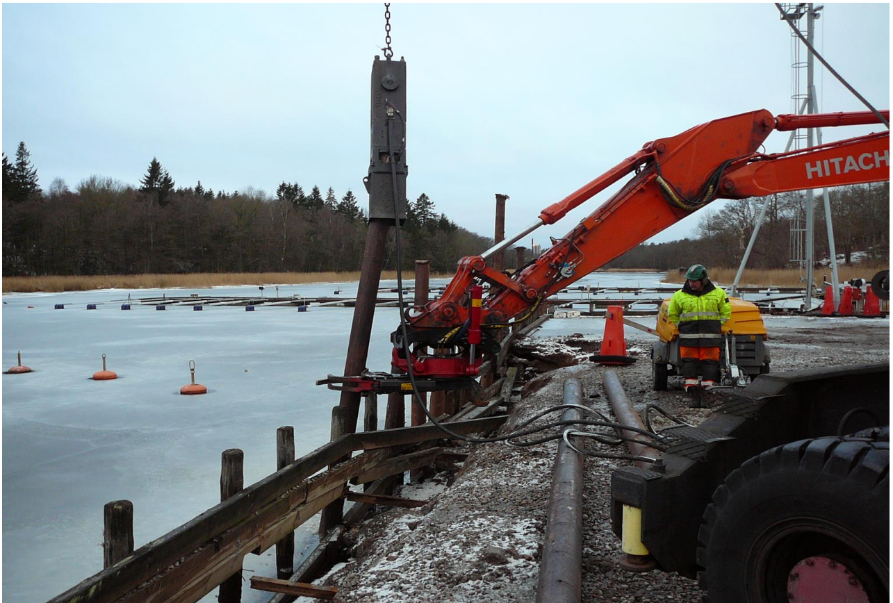
Reparation av östra kajen.
