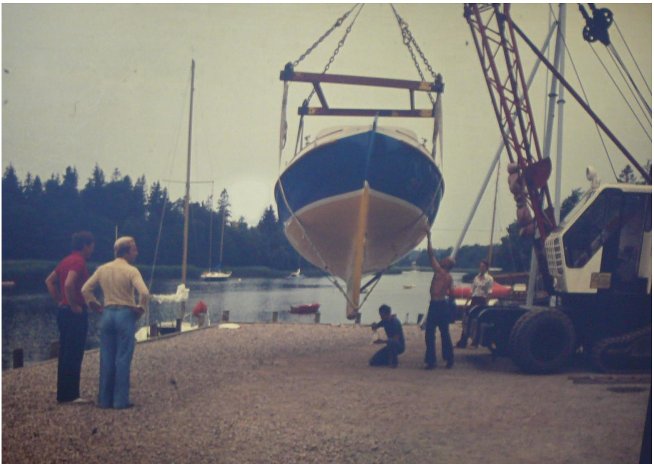
Sjösättning med den första kranen.
